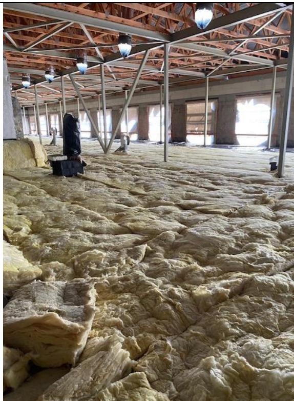
Dodatočné zateplenie strechy
